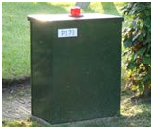
Figuur F.6 Een pompunit van het drukriool dient per 6 huishoudens geplaatst te worden. Zie Tekstbox voor meer info. Bron afbeelding: http://www.staphorst.nl/inwoners/onderwerpen-a-z_42831/product/melding-rode-lamp-drukriolering_787.html
