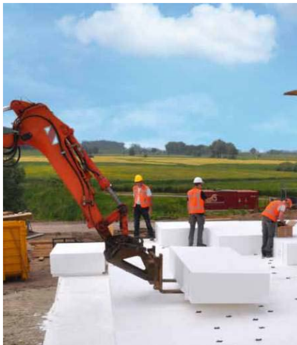
Figuur V: Toepassing van EPS in de wegenbouw (Bron: Isobouw Powerblok Brochure, blz. 2)
